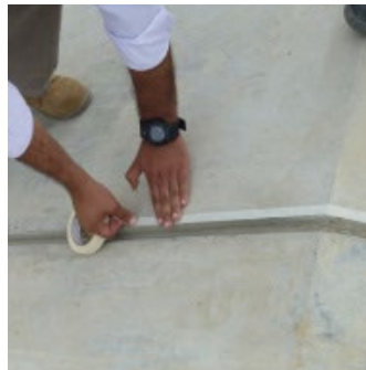
2 Opcional: Se colocara una cinta masking tape
