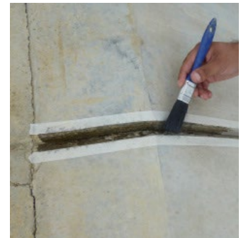
4 Aplicar imprimante PER PRIMER POX o PER PRIMER 75
