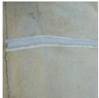
8 Acabado final. Retirar Cinta masking tape.
