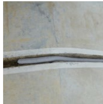
3 Colocar PER BACKER ROD en la junta como material de respaldo
