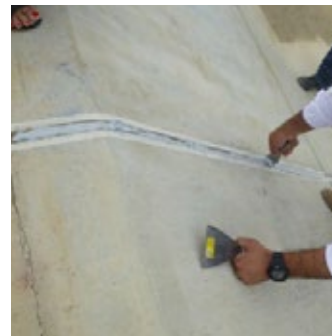
7 Se termina la aplicacion nivelando con una espátula y retirando los excesos con la misma
