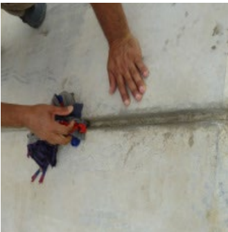
1 Limpieza de la superficie de la junta
